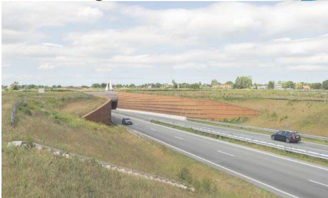
▲ Centrale as, Friesland NL, ontworpen door H+N+S
