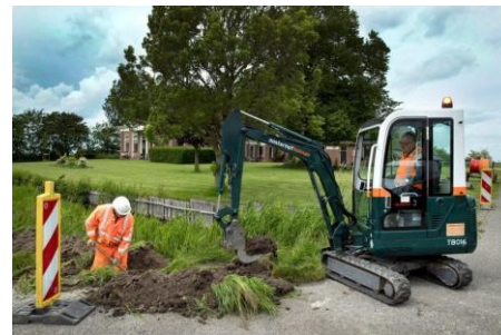
▲ Aanleg van glasvezel. Foto: snelinternetgroningen.nl.
