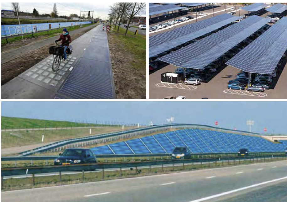
Voorbeelden dubbelgebruik van zonnepanelen: zonedijk Eemshaven (bron: Solarfields), boven een parkeerterrein en op het dijklichaam langs de Afsluitdijk (bron: De Ingenieur)
