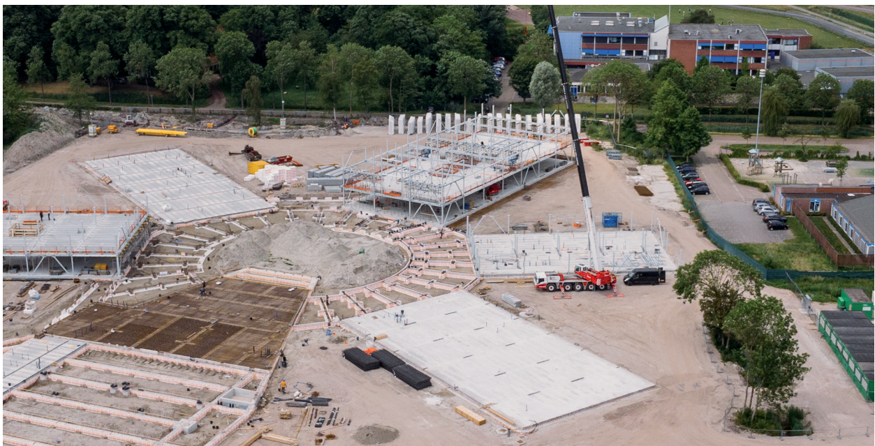
Bouw van de campus in Appingedam.
