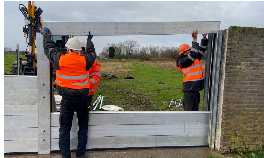
Sluiten van een coupure met aluminium schotten.
