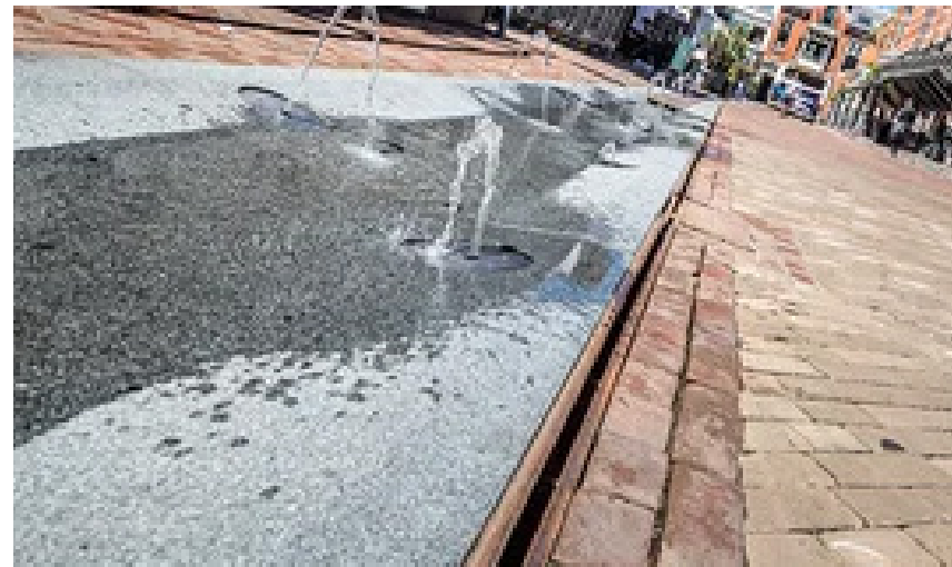
lijngoot van cortenstaal
