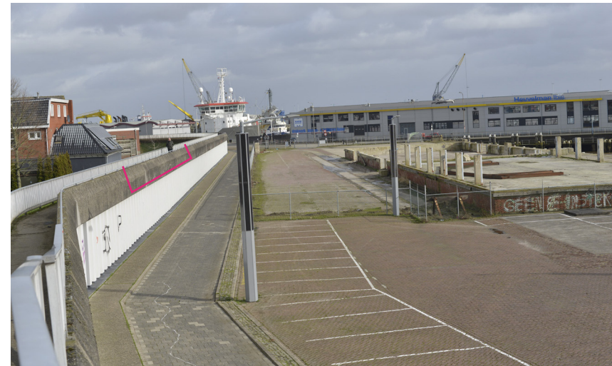
Betonnen rand openen en aansluiten op pad op de kering
