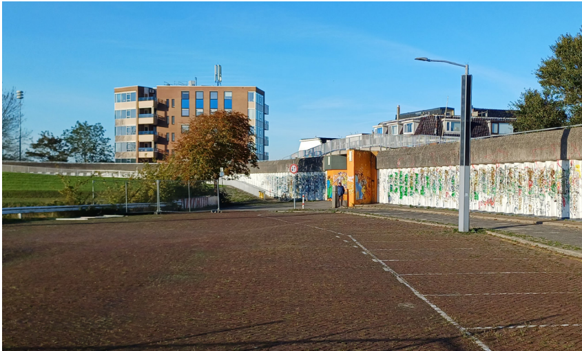
De damwand is inmiddels opgeschoond maar de historie maakt duidelijk dat de wanden zich lenen voor graffiti. Graffiti draagt bij aan een 'plek waar je niet wilt zijn als het donker is'
