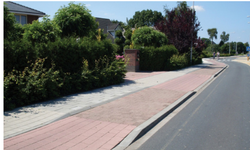
Banden toepassen in lichtgrijs beton.
